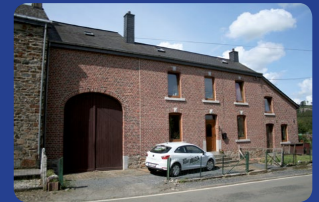
Habitation avec porte de grange témoignant de ce passé céréalier
